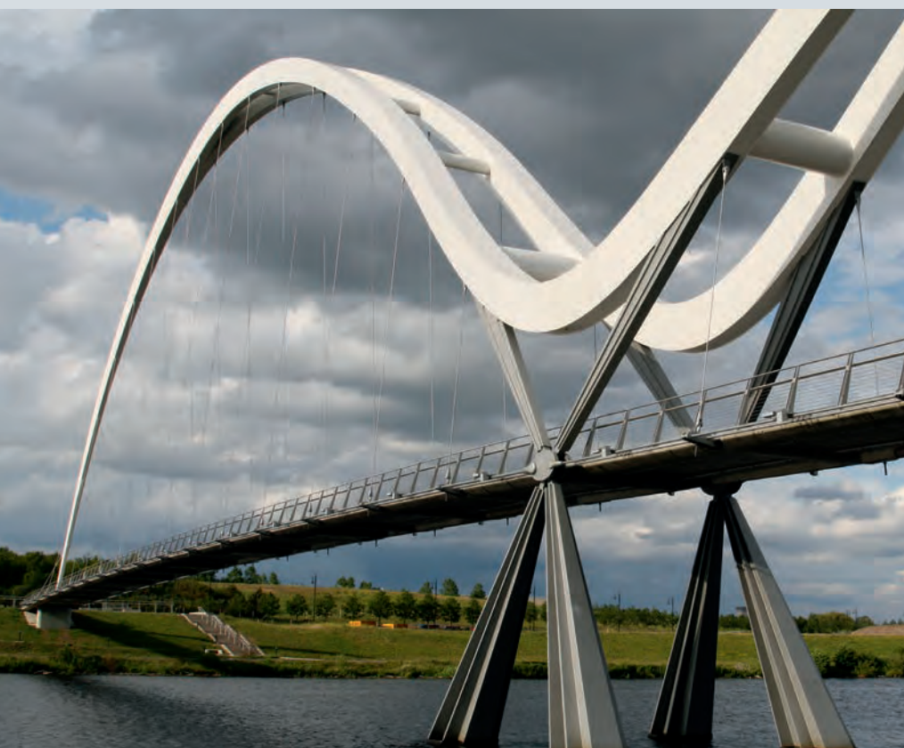
Infinity Bridge, Großbritannien
