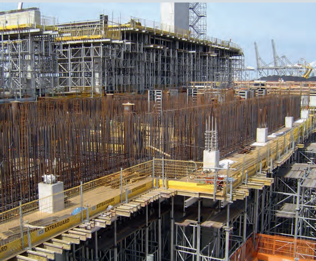
Bauausführung Turbinentisch – Rotterdam, Niederlande
