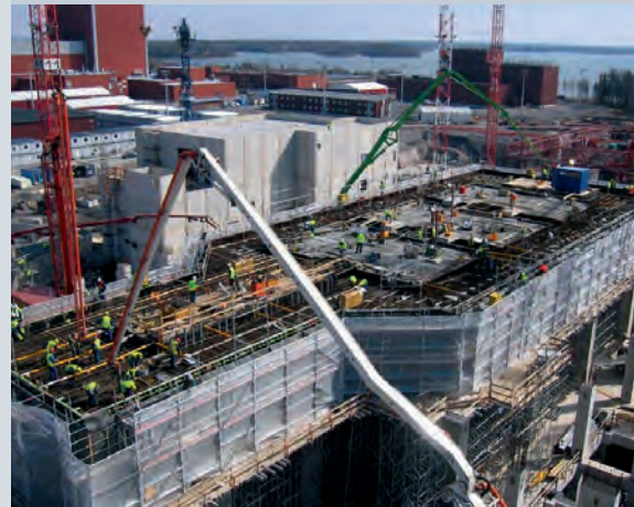
Betoniervorgang Olkiluoto-3, Finnland
