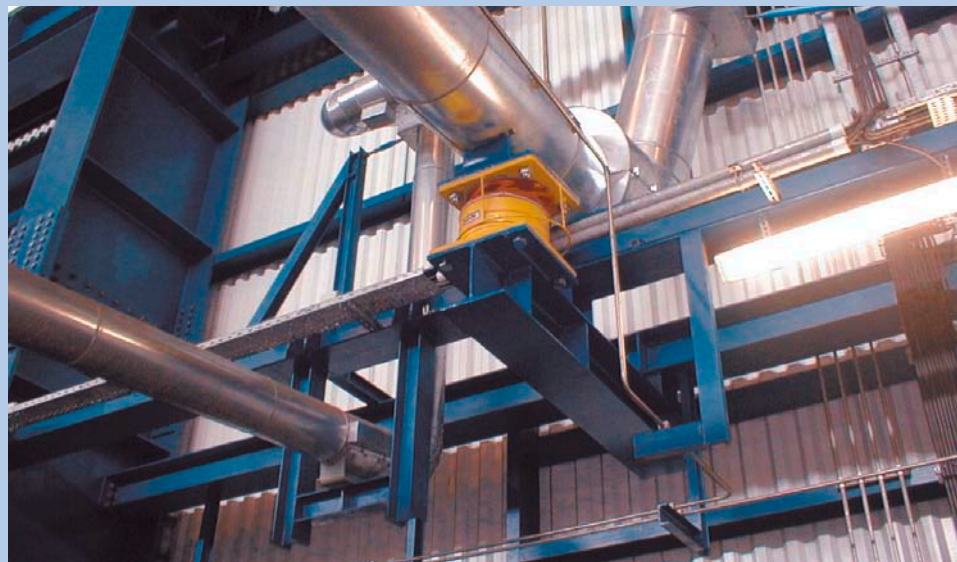
Einbaubeispiel eines Rohrleitungsdämpfers Typ VES
